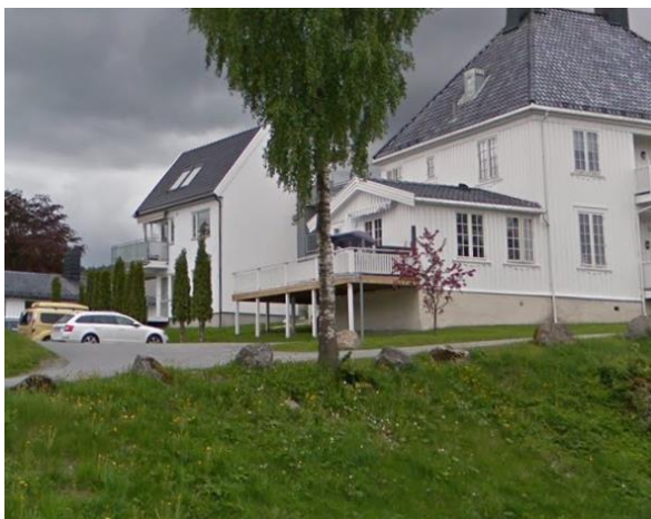
Grossflächiger Balkon, der unterquert werden kann im Sichtfeld → als Überdachung kartieren.
