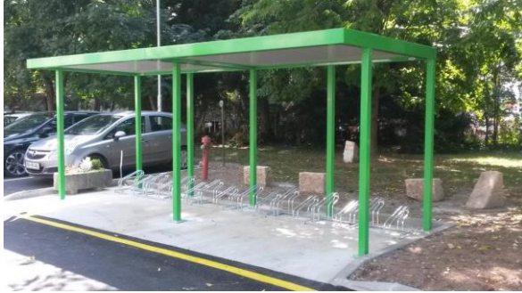
Kann das Objekt gequert werden → als Dach kartieren.
