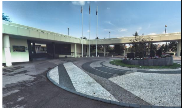
Point B Niveau inférieur, vue du SE
