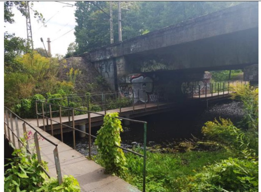
Standort A , Ansicht von NW
