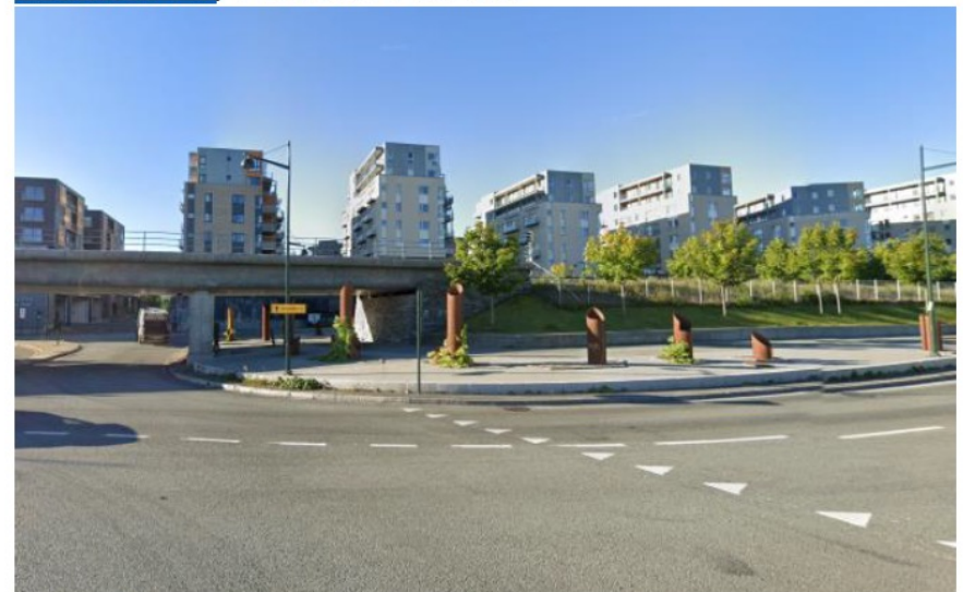
Standort C , Ansicht von N
